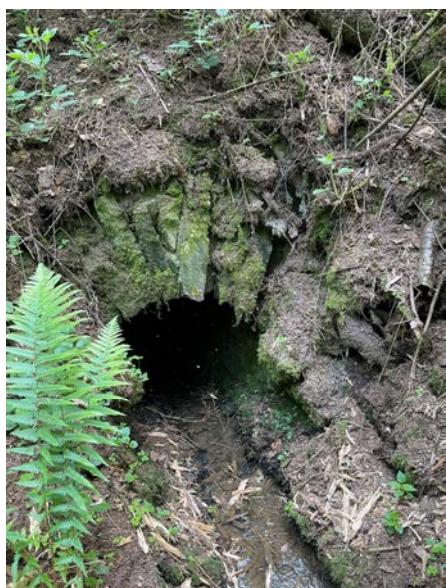
Die Dörrenbacher Rösche wurde in zwei Bauphasen, vermutlich im frühen 19. Jahrhundert errichtet. Zum einen mit einem runden etwa einen Meter messenden Querschnitt, zum anderen mit einem unten flachen und darüber gewölbten Querschnitt.
